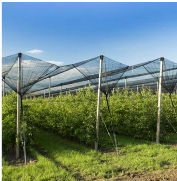
DPAK - Installato in un formato ad anello con strozzatura su un palo di cemento
