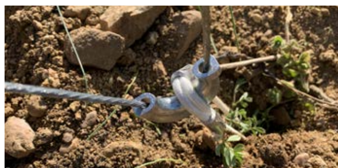
Sopra: installazione fune sulla parte superiore del palo in legno Sotto: Accessorio anti scivolo
