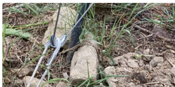
Sopra: ancora Apex installata Sotto: protezione fune
